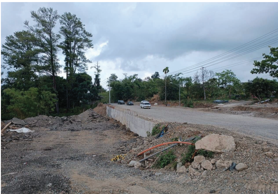
Gambar C. 2 Lokasi dinding penahan tanah
