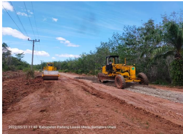
Gambar C.2 pekerjaan penghamparan material
