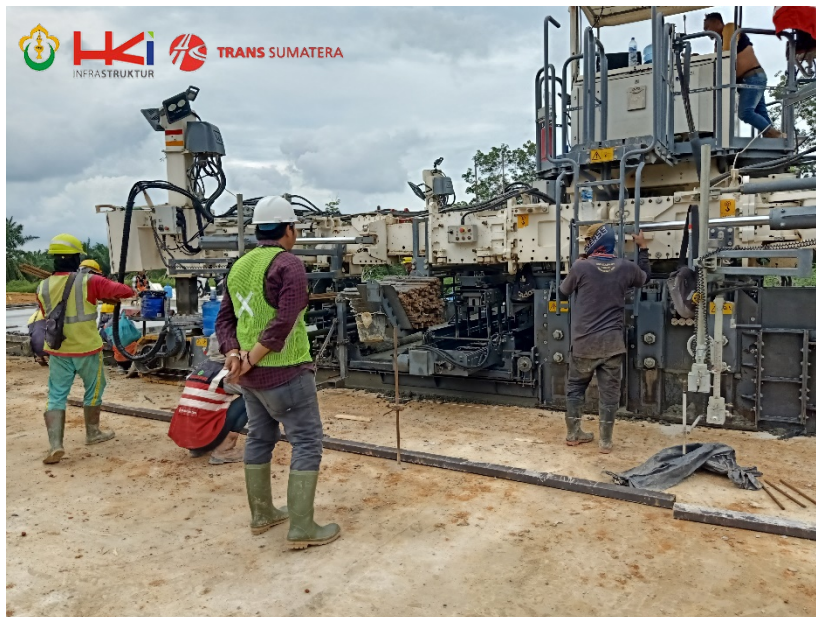
Gambar C.6 Pengerjaan rigid pavement
