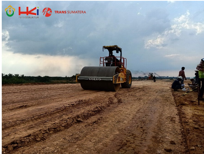
Gambar C.1 Pemadatan tanah timbunan
