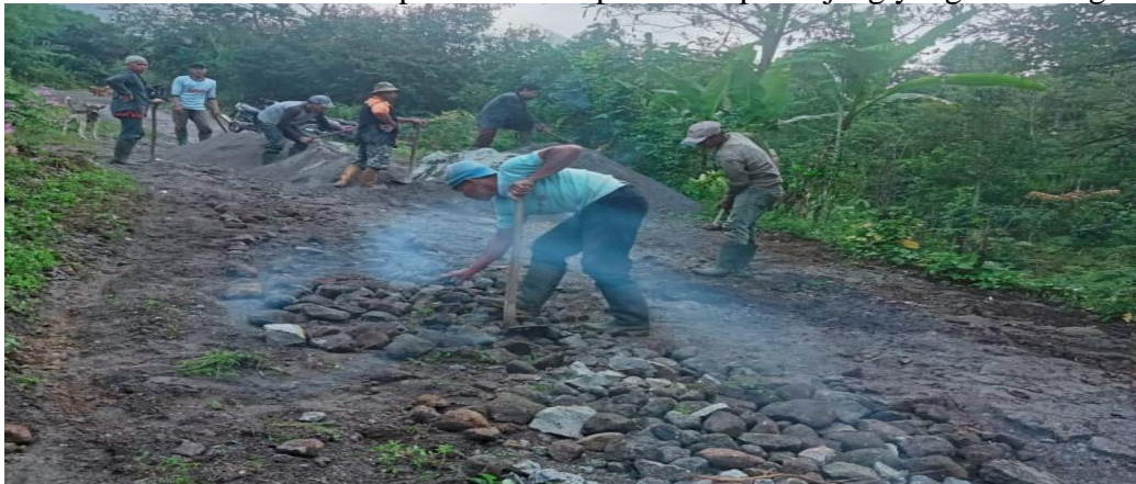
Gambar 1.1. Lokasi Desa Pantan Pediangen Jalan Lintas Kabupaten Bener Meriah
