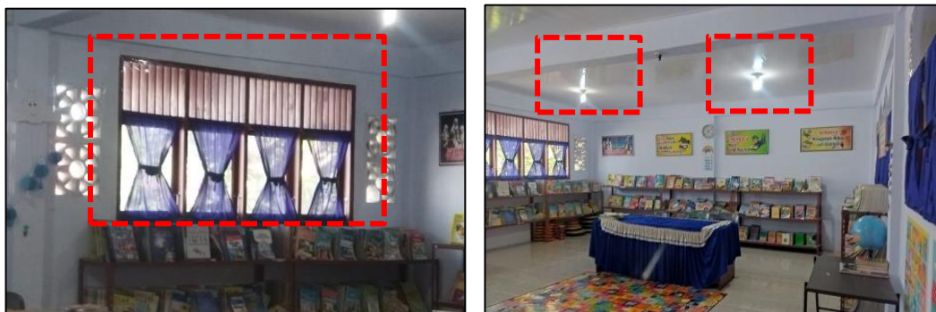
Gambar 4.20 Kondisi pencahayaan dan penghawaan pada ruang kelas Sumber: Dokumentasi lapangan (2024).
