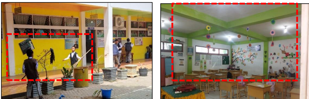
Gambar 4.22 Kondisi warna eksterior dan interior bangunan Sumber: Dokumentasi lapangan (2024).
