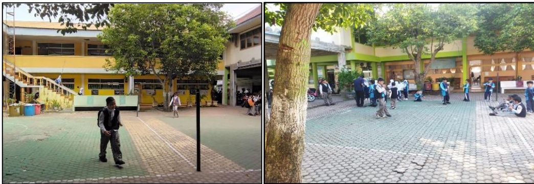
Gambar 4.6 Kondisi struktur bangunan dari luar Sumber: Dokumentasi lapangan (2024)
