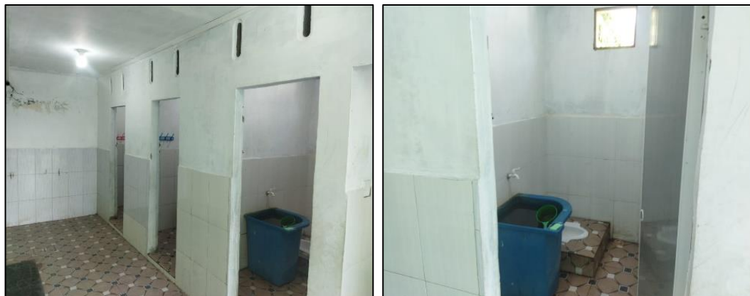
Gambar 4.14 Kondisi toilet siswa dan siswi Sumber: Dokumentasi lapangan (2024)
