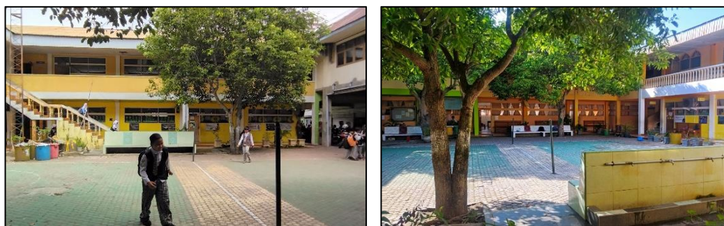
Gambar 4.23 Kondisi lanscape sekolah Sumber: Dokumentasi lapangan (2024).
