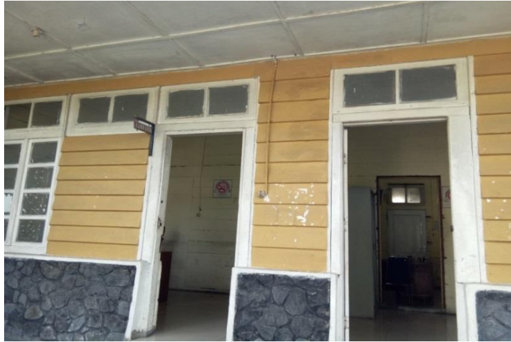
Gambar 4. 19 Bouvenlicht /lubang ventilasi bangunan (dokumentasi penulis, 2023)
