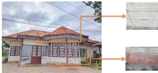
Gambar 4. 67 Dinding (dokumentasi penulis, 2023)
