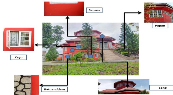
Gambar 4. 35 Material bangunan (dokumentasi penulis, 2023)
