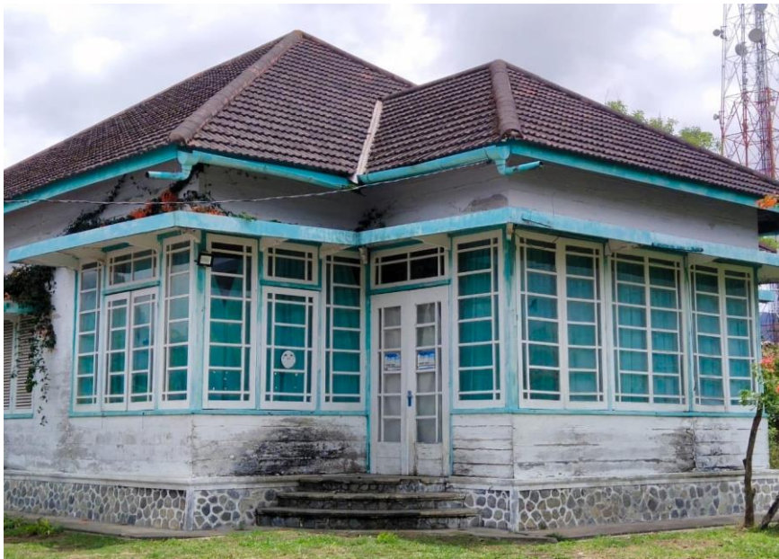
Gambar 4. 20 Bangunan (3) Rumah Raja Uyem (dokumentasi penulis, 2023)
