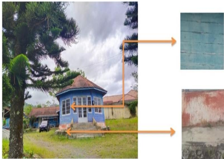
Gambar 4. 71 Dinding bangunan (dokumentasi penulis, 2023)
