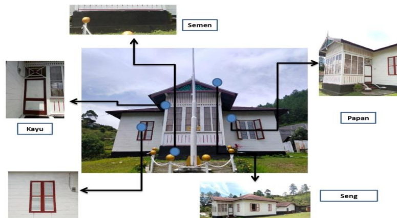
Gambar 4. 47 Material bangunan (dokumentasi penulis, 2023)
