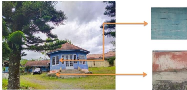
Gambar 4. 77 Dinding (dokumentasi penulis, 2023)
