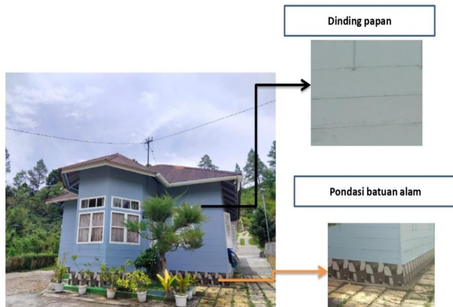
Gambar 4. 56 Dinding (dokumentasi penulis, 2023)
