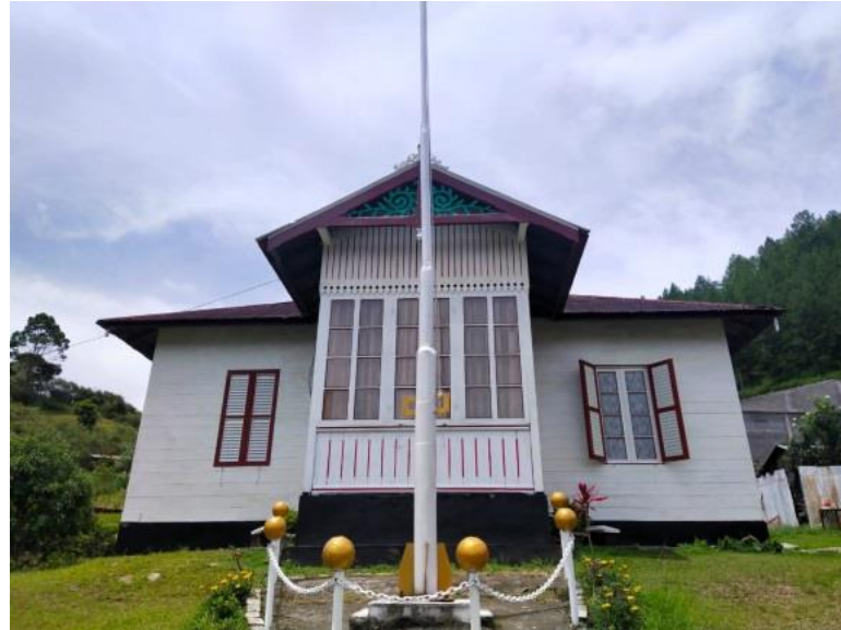
Gambar 4. 43 Bangunan (5) Rumah Tinggal Bapak H.Abdurrahman (dokumentasi penulis, 2023)
