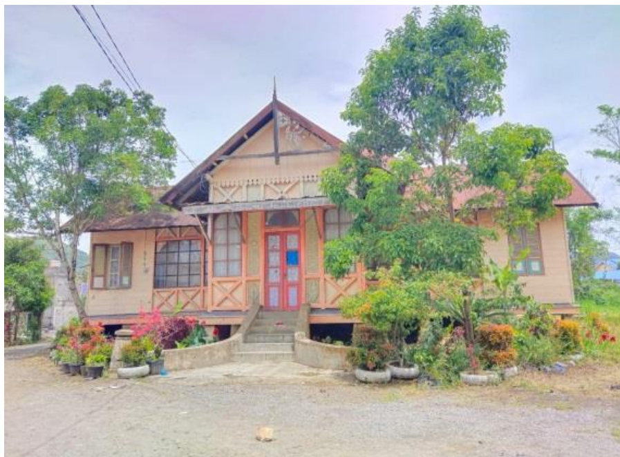
Gambar 3. 3 Bangunan (1) Rumah Reje Uyem (dokumentasi penulis, 2023)
