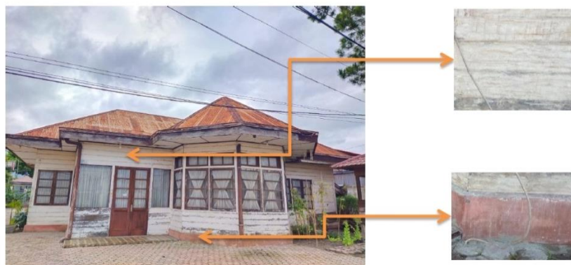
Gambar 4. 63 Dinding (dokumentasi penulis, 2023)
