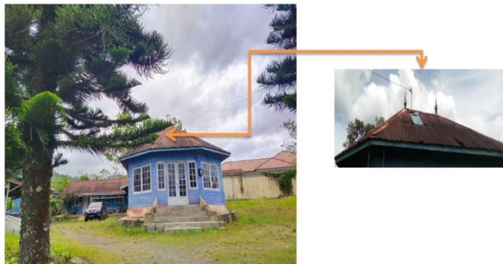
Gambar 4. 70 Atap Bangunan (dokumentasi penulis, 2023)
