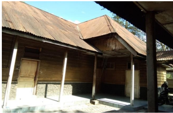
Gambar 4. 18 Atap Bangunan (dokumentasi penulis, 2023)
