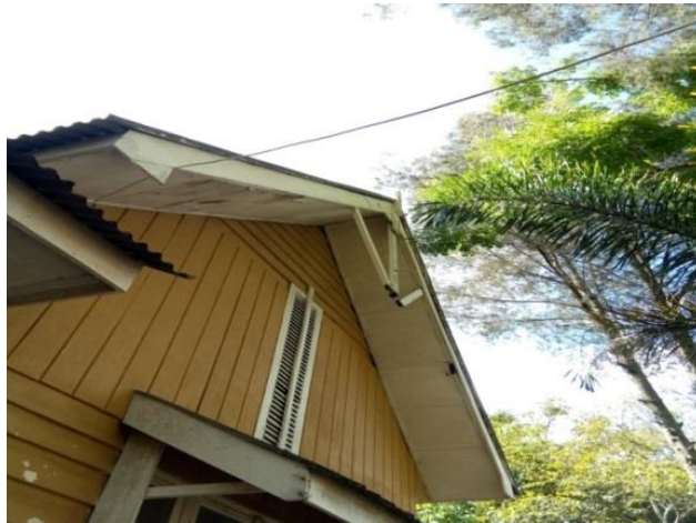
Gambar 4. 14 Goveltoppen bangunan (dokumentasi penulis, 2023)
