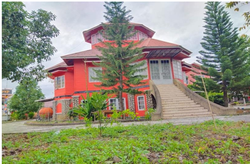
Gambar 4. 30 Bangunan (4) Istana Reje Ilang (dokumentasi penulis, 2023)
