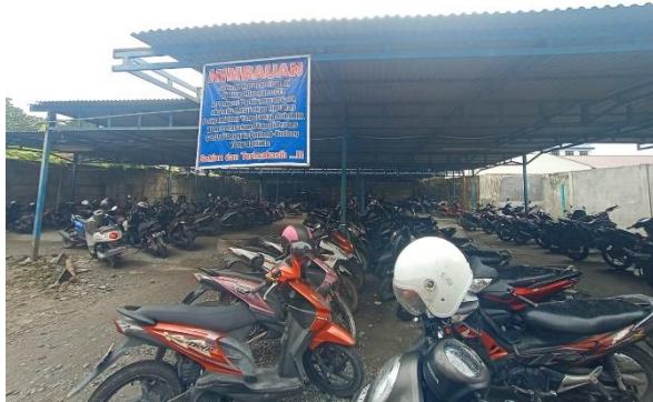
Kondisi Eksisting Parkir Sepeda Motor RSU Imelda Pekerja Indonesia Medan
