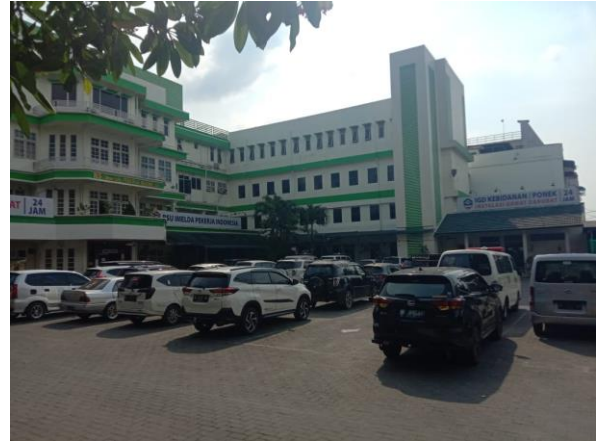
Kondisi Eksisting Parkir Mobil Penumpang RSU Imelda Pekerja Indonesia Medan
