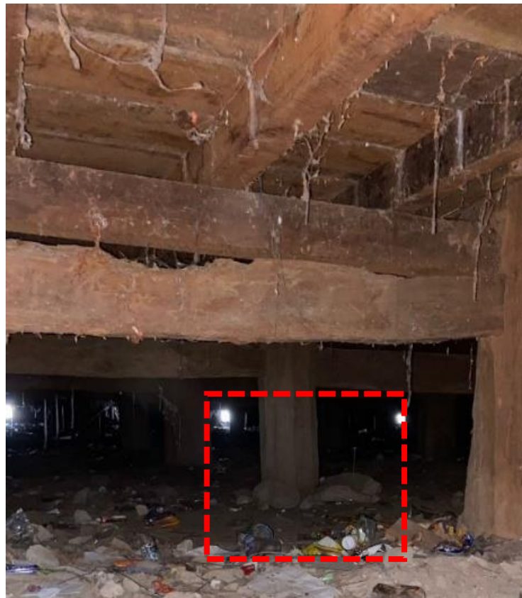
Gambar 4. 7 Pondasi Masjid Raya Lima Kaum ( Dokumentasi Penulis 2023)
