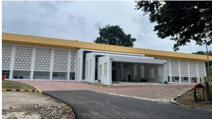
Gambar 1.2 Gedung RKU A Setelah Pembongkaran
