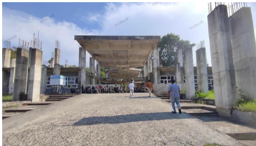
Gambar 1.1 Gedung RKU A Sebelum Pembongkaran
