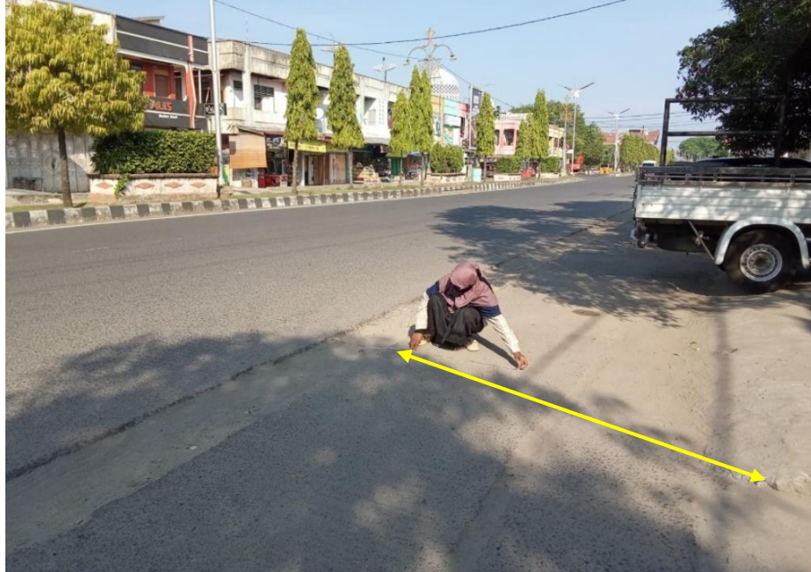
Gambar 4.3 : Kondisi Bahu Jalan Merdeka
