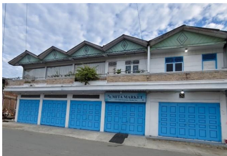
Gambar 3. Kondisi Fisik Bangunan Pasar Modern Mita Market (Penulis, 2026)
