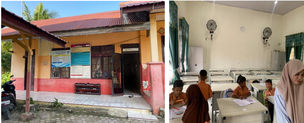
Gambar 1. 2 Kondisi Alih Fungsi Ruang Laboratorium dan Gudang Menjadi Ruang Kelas Darurat
