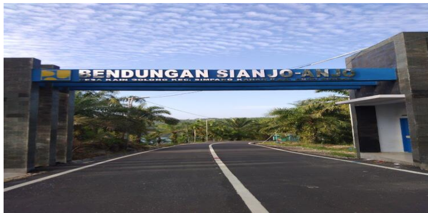
Gambar 1. 2 Jalan Waduk Sianjo-Anjo (Tahun 2024)
