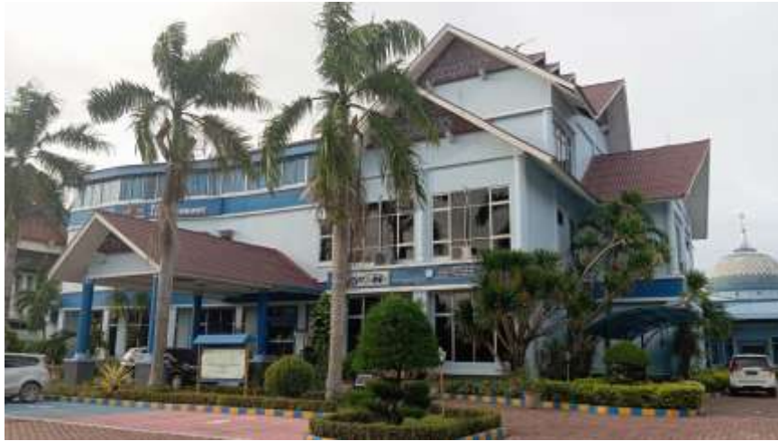
Gambar 1.2 Kantor Pelayanan Perbendaharaan Negara Lhokseumawe
